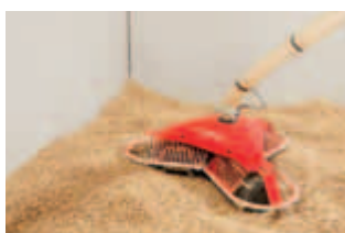
Skladovací priestor s privádzaním ku kotlu na pelety systémom „krtko“.
